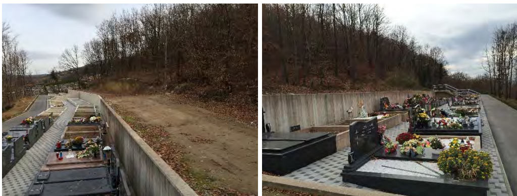
Slika 1.1.-6.,7. I etapa izgradnje
